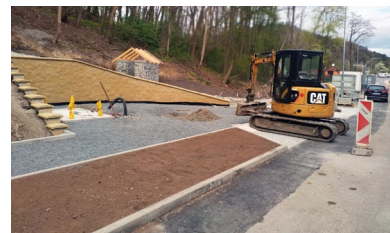
Výstavba chodníku v Kralupské ulici
