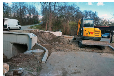
Výstavba propustku v Lososnici
