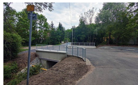
Nový propustek v Lososnici
