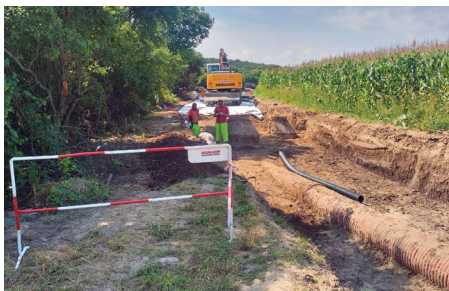
Výstavba cesty mezi ulicemi V Loučkách a U Dvora
