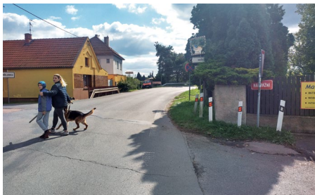
Tímto úsekem by měla začít výstavba nových chodníků v Zagarolské ulici
