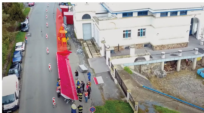
Na instalaci protipovodňových zábran letos naštěstí nedošlo. Fotografie je ze zkoušky prováděné v roce 2020.
