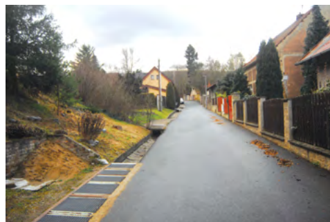
Potrubí a žlab v místní ulici podélně s Kralupskou bude sloužit pro odvádění dešťových vod z Lešan.
