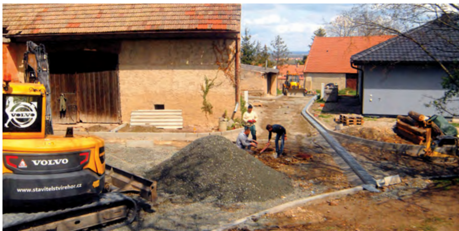
Pokládka dešťové kanalizace a rekonstrukce ulice U Kapličky
