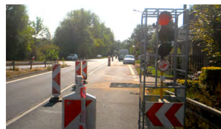
Výstavba kanalizace ve Velvarské ulici si vyžádala částečnou uzavírku komunikace a kyvadlový provoz dopravy.
