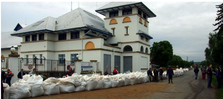
Protipovodňová zábrana v Zagarolské ulici (3. 6. 2013)
