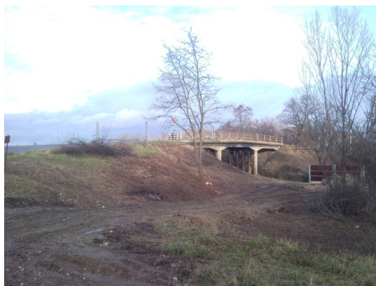
Přípravné práce na rekonstrukci nadjezdu
