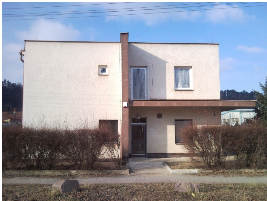
Zrenovovaná budova čp. 313 v Zagarolské ulici, jejíž prostory budou sloužit obecní knihovně, mateřské škole i Klubu seniorů
