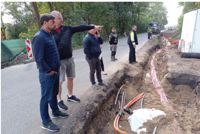
Kontrolní den výstavby chodníku v Kralupské ulici
