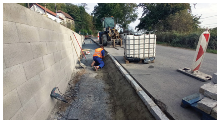
Nová opěrná zeď pod ulicí Na Vinici
