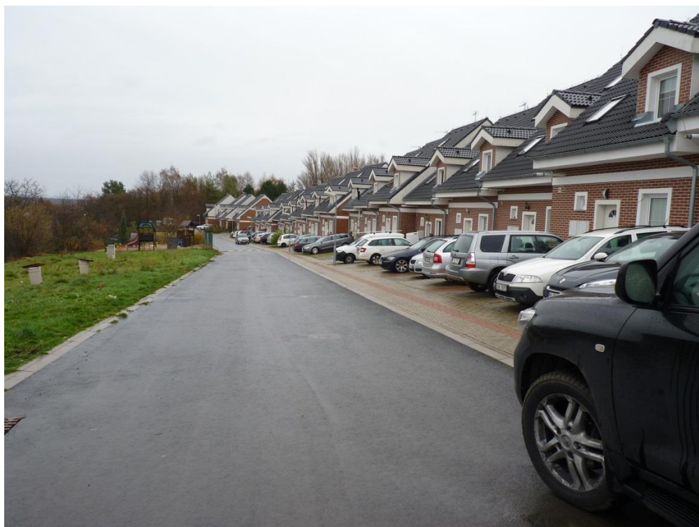
Obr. 7-20 Veškeré dešťové vody jsou v Anglickém resortu II svedeny do vsakovacího objektu. V nedávném období byl povrch vsakovacího objektu částečně zastavěn dětským hřištěm (dětské hřiště na fotce vlevo).
