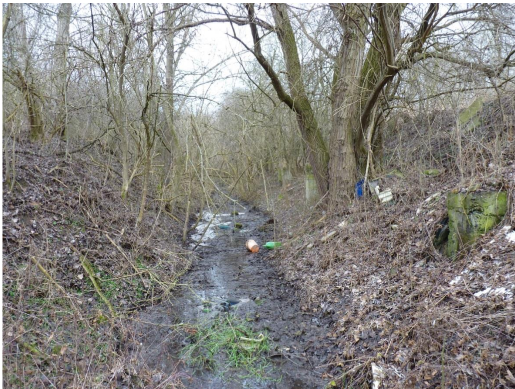
Obr. 7-30 Zdnedbané koryto Korytnice
