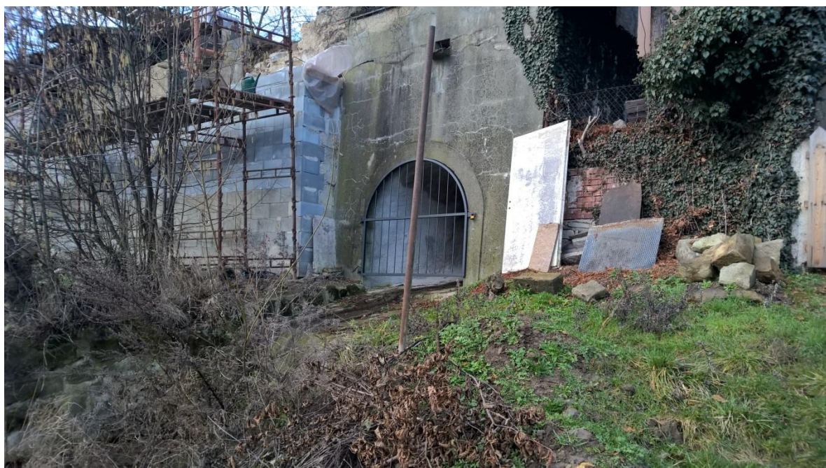
Obr. 7-27 Výpust hradební štoly do Vltavy
