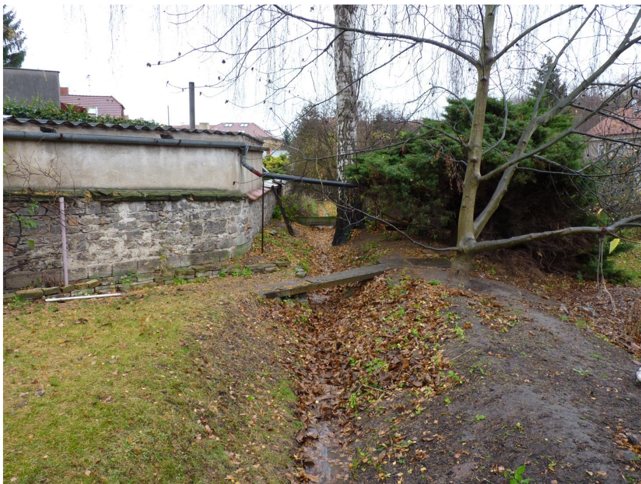
Obr. 7-25 Otevřený dešťový příkop vedený mezi zahrádkami
