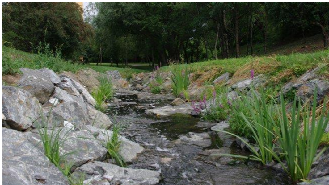
Obr. 7-32 - Balvanitá úprava s výsadbou mokřadních rostlin
