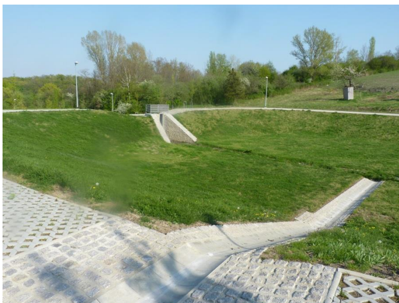
Obr. 7-22 - Příklad průtočné retenční nádrže s cyklostezkou v koruně hráze (Zelené město - Hrdlořezy).
