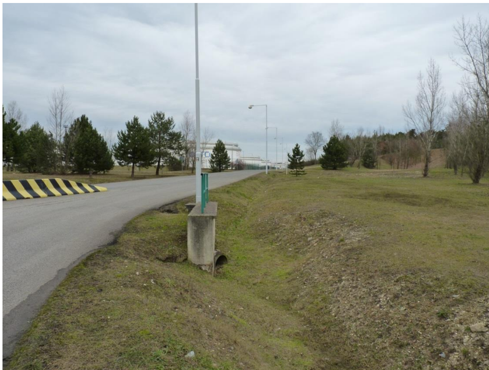
Obr. 7-37. - Odvodňovací příkopy příjezdové komunikací CTR MERO jsou svedeny systémem funkčních a polo-funkčních příkopů a propustku na ul. Velvarská, kde vytékají na silnici.
